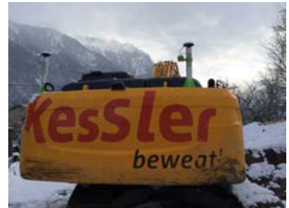
Einrichten eines Baggers mit GNSS-Empfängern
