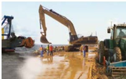
Maschinensteuerung mit dem AsteRx-U
