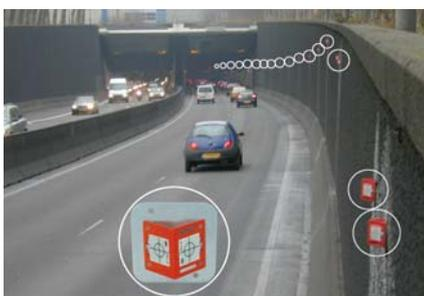
in die bereits einbetonierten Ankerhülsen mit Komponentenkleber eingedreht und auf die Messposition ausgerichtet. Ankerhülsen sind häufig am Kragarm und in der Kappe im Abstand von ca. einem Meter einbetoniert und eignen sich aufgrund ihrer Lage hervorragend zu Vermessungszwecken. Lästige Bohrungen im armierungsreichen Beton entfallen, ebenso die gefährlichen und teuren Straßensperren, da zur Vermessung die Begehung der Brücke nicht mehr nötig ist.
