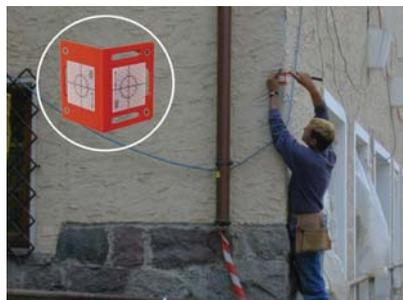
Die Plaketten RS90 werden mit Dübel und Schraube montiert und ermöglichen das Anpeilen der Vermessungspunkte aus nahezu jeder Position. Eine Achse z. B. kann von vorne, unten und oben angepeilt werden. Bei Kletterschalungen schützt das "Dach" vor Betonschlamm.
