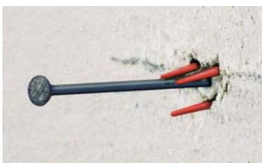
Die elastischen "Putzpinsel" sorgen dafür, dass der Meterriss bis nach den Putzarbeiten gesichert bleibt und einfach wiederzufinden ist. Auch Höhen und Achsen werden bis über die Putzarbeiten hinaus gesichert. Um eventuellen Manipulationen aus dem Wege
