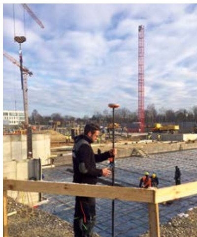
Abstecken von Punkten und Achsen im Tiefbau
