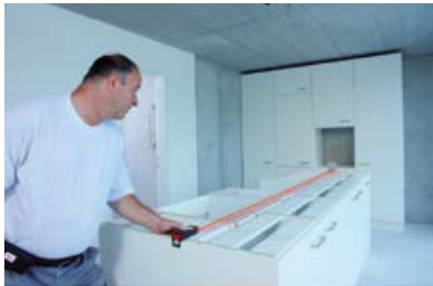
Vermessung im Innenbereich
