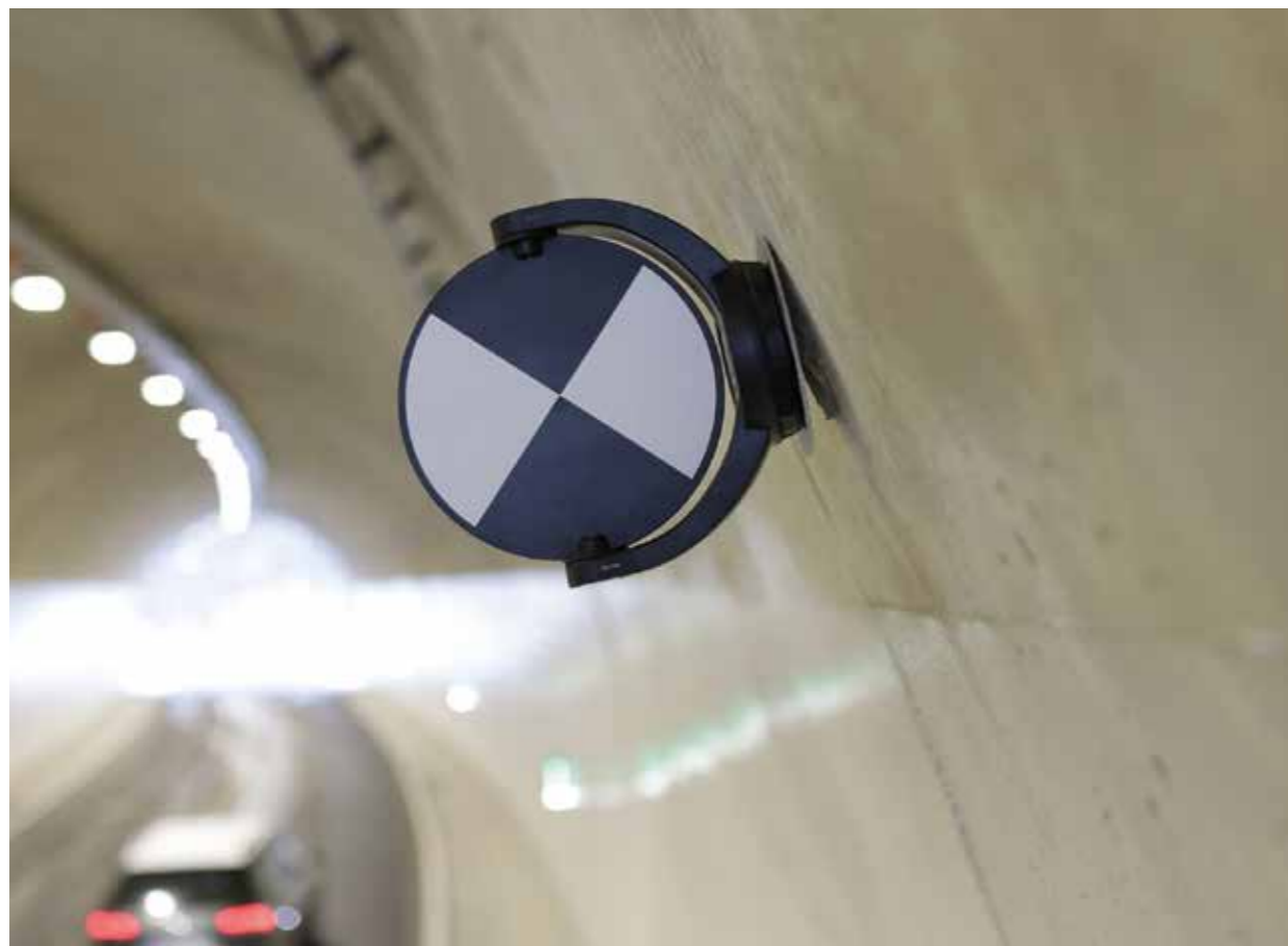
Laserscanner-Marke RSL422M im Tunnel
