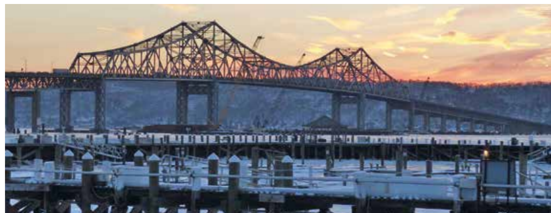
Brückenbeobachtung (Tappan Zee Bridge USA)
