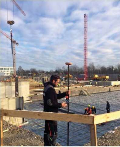
Abstecken von Punkten und Achsen im Tiefbau
