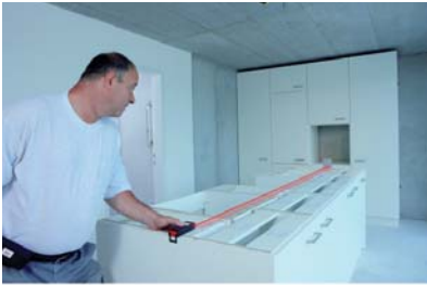
Vermessung im Innenbereich
