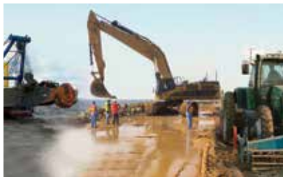
Maschinensteuerung mit dem AsteRx-U
