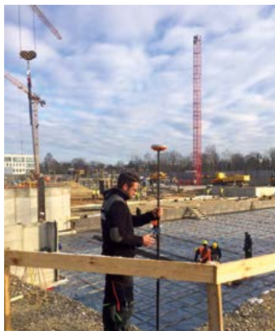
Abstecken von Punkten und Achsen im Tiefbau
