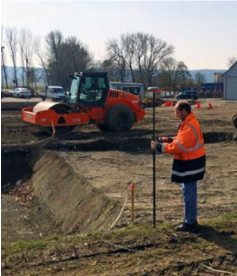
Abstecken von Punkten und Achsen im Tiefbau
