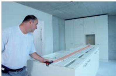
Vermessung im Innenbereich
