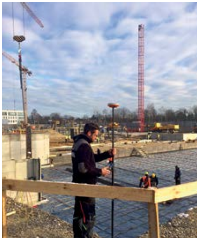
Abstecken von Punkten und Achsen im Tiefbau
