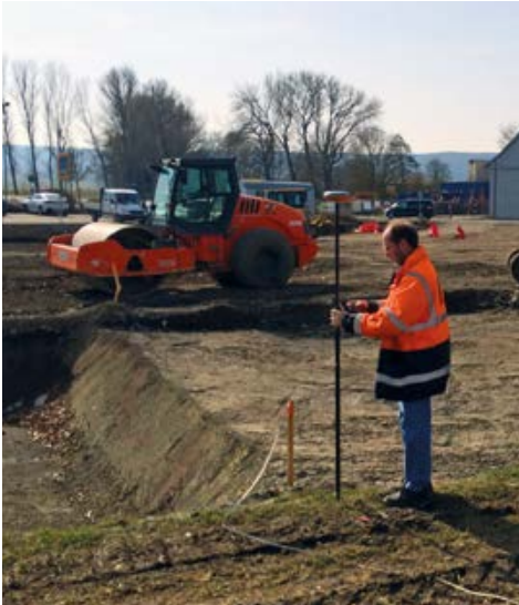
Abstecken von Punkten und Achsen im Tiefbau
