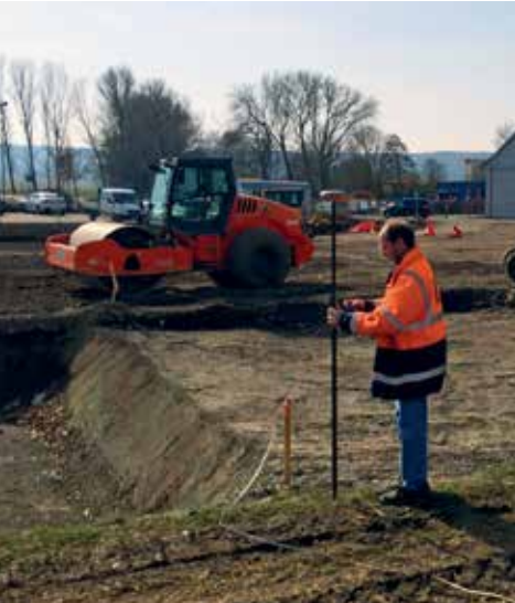
Abstecken von Punkten und Achsen im Tiefbau
