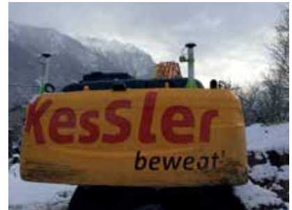
Einrichten eines Baggers mit GNSS-Empfängern
