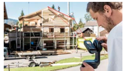
X4 - Messung der Dachschräge mit Hilfe des DST360 Adapters
