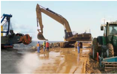
Maschinensteuerung mit dem AsteRx-U
