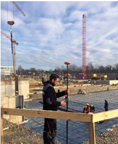
Abstecken von Punkten und Achsen im Tiefbau
